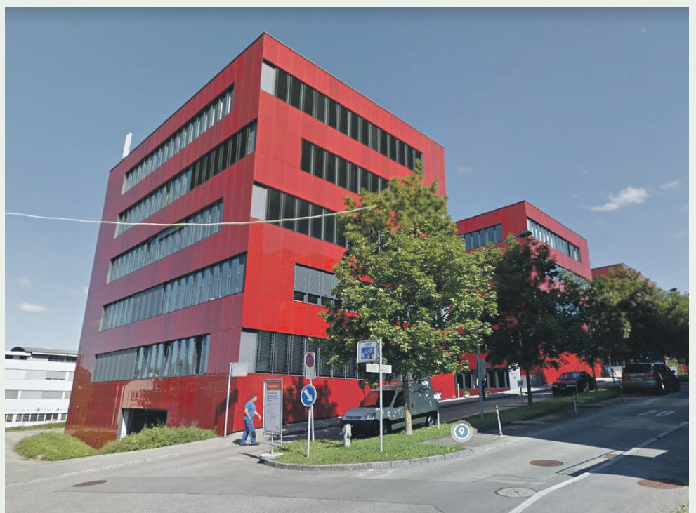
In diesem leerstehenden Bürogebäude an der Berner Nussbaumstrasse soll neuer Schulraum entstehen.
